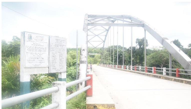
Fotografía 5.1.25. Fotografía: Puente ubicado en el recinto Playa de Muerto.
