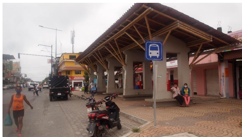
Fotografía 5.1.18. Fotografía: Instalaciones de parada de buses inter cantonales e inter provinciales en la cabecera parroquial.
