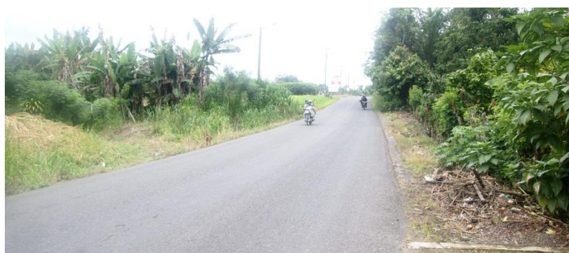
Figura 66. Vía con doble tratamiento, hacia el Recinto Playa de Muerto.
