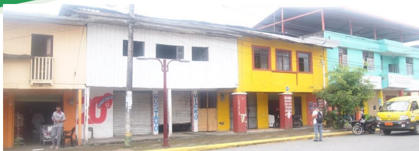
Figura 56. Viviendas del centro poblado a dos aguas con construcciones mixtas y de hormigón. Junio/ 2020.
