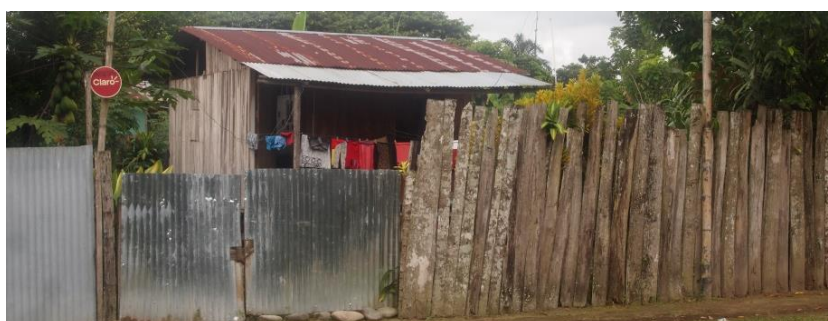
Figura 57. Casa del barrio El Tambo a dos aguas de madera. Junio/2020.
